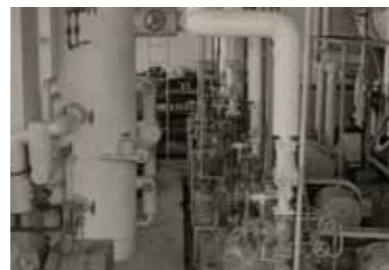
ブースター方式の高速多気筒冷凍機。
