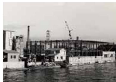
名古屋市中心部を流れる中川運河沿いに建設され、凝縮器の冷却水は中川から取水していた。
