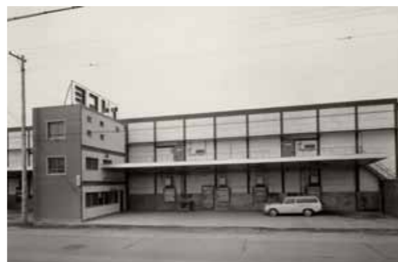
旧名古屋工場(1965 (昭和40) 年) 1988 (昭和63) 年に売却 現在でも運送会社の倉庫として利用されている。
