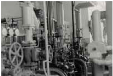
立型冷凍機 (中須製作所製) 中須製作所製の立型冷凍機は、横浜工場と養老工場の2カ所で使用されていた。
