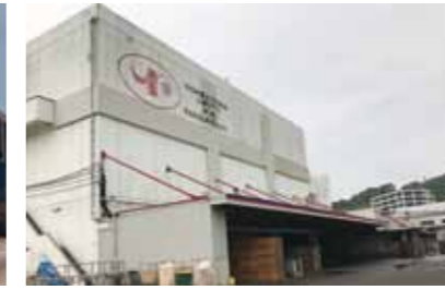
長崎工場2号棟 [1985 (昭和60) 年]
