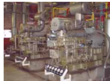
高速多気筒冷凍機(前川製作所製)
