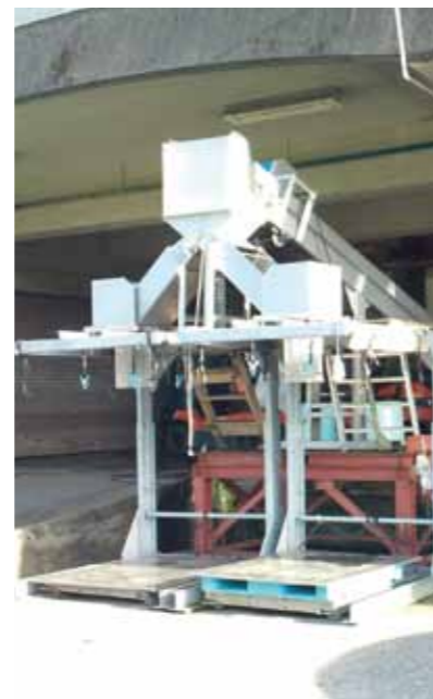
フレコンバック詰め作業用コンベアライン。
