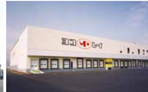
石狩物流センターC館〔2003 (平成15) 年〕
