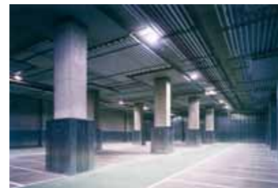
当社最後の天井ヘアピンコイル冷却方式。
