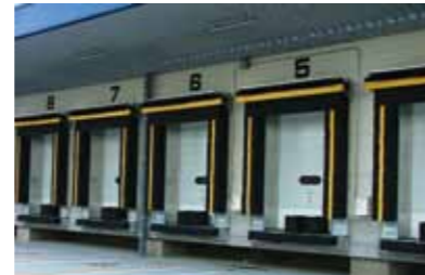
サイドバットを一体式から分割式に変更し、シェルター上部より外気が入らないようにオーバースライダーと連動した電動ジャバラカーテンを導入。
