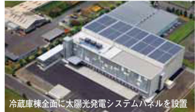
冷蔵庫棟全面に太陽光発電システムパネルを設置
