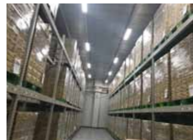
6,093パレットの移動ラック
