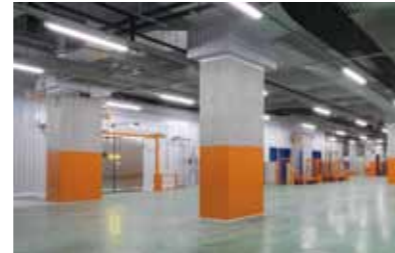
4階多目的スペース
