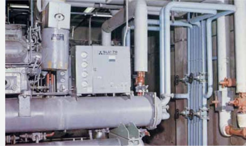
熱田工場で使用されていたR-22対応の冷凍機。
