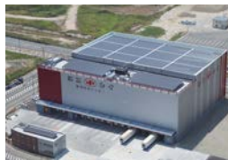
夢洲物流センター Yumeshima Logistics Center
