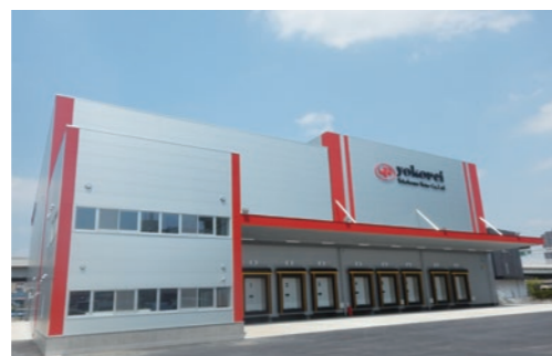
横浜みらいサテライト 全国各地で行っていたフォークリフトなどの現地研修を大人数で一度に行うことができる施設です。また、研修施設としてだけでなく、京浜地区の冷蔵倉庫逼迫の緩和につなげるため、横浜物流センターのサテライト機能を持った冷蔵倉庫として稼働している施設です。
